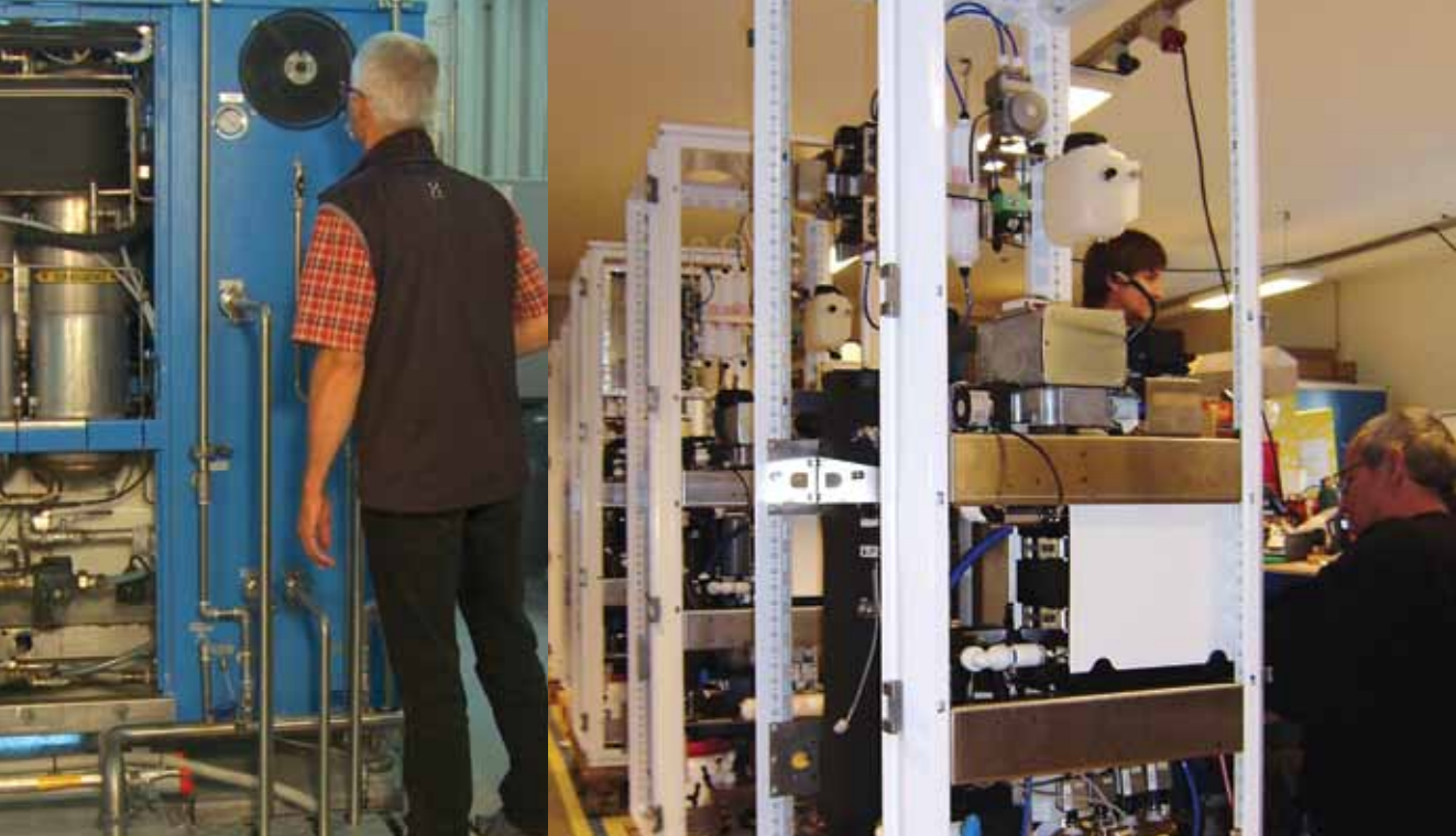
Brændselscelledrevet arbejdskøretøj, elektrolyseanlæg og produktion af mikrokraftvarmeanlæg. Fotos: Serenergy A/S, Energinet.dk, Dantherm Power A/S
